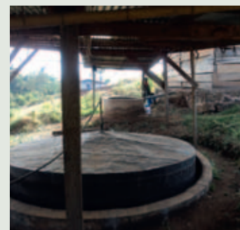
Figura 9. Digestor de biogás comunicado con establo porcino existente en la granja
