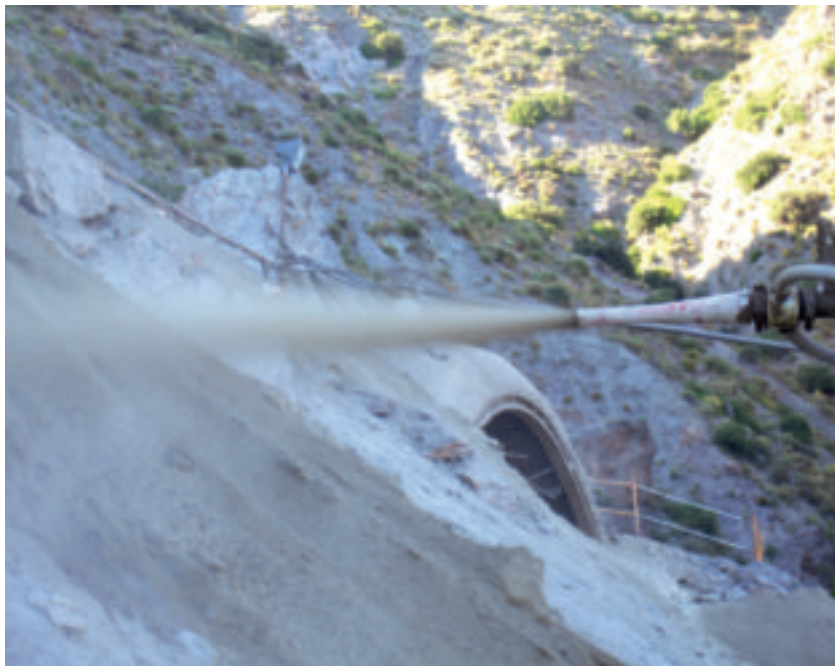
Gunitado con HFR de una ladera.
