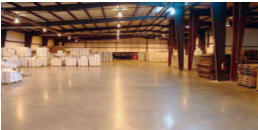
Solera industrial armada con fibra sintética estructural.
