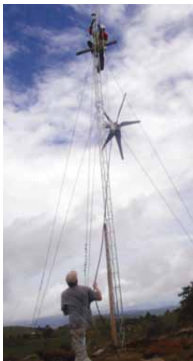
Levante del aerogenerador.
