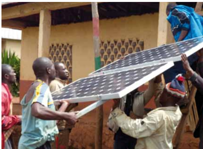
Montaje de paneles fotovoltaicos en Bambdzeng.
