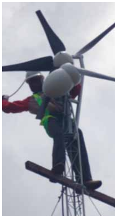
Montaje del aerogenerador.
