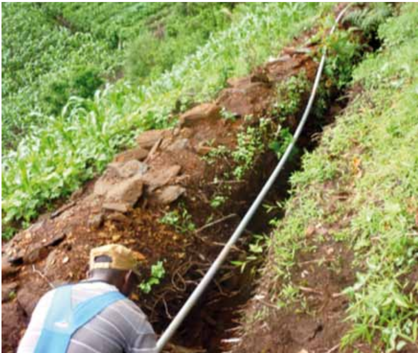
Zanja línea turbina-Bambdzeng.
