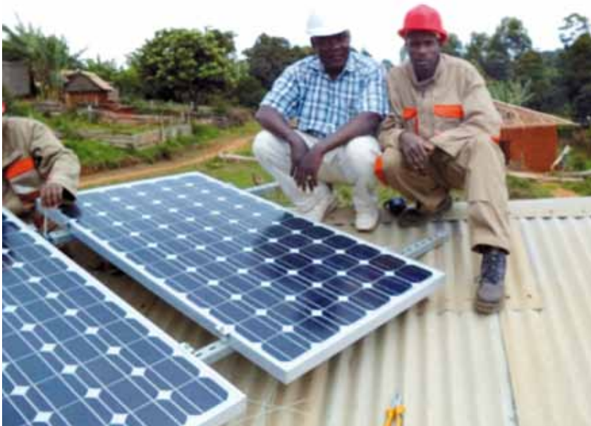
Montaje de dos paneles de 180 W en la escuela cristiana de Bambdzeng.
