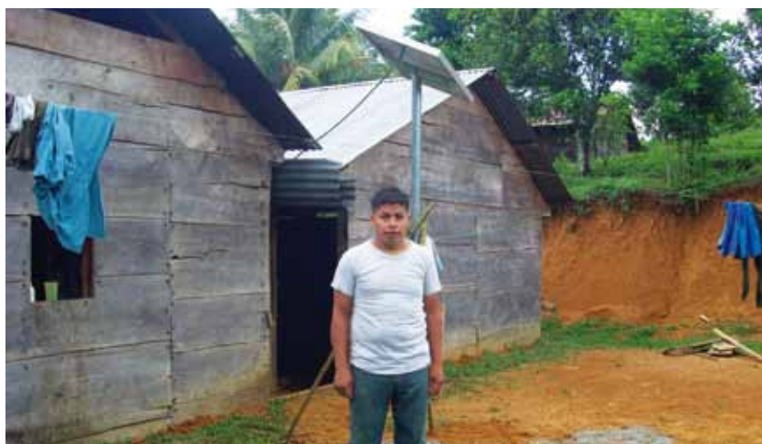
Uno de los sistemas fotovoltaicos instalados en la comunidad rural de Alta Verapaz.
