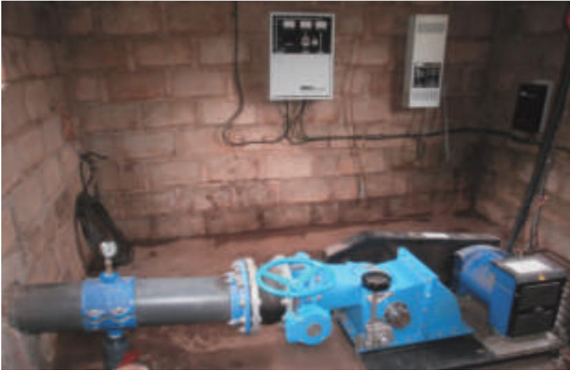
Válvulas, manómetro y cuadro eléctrico operación turbina.
