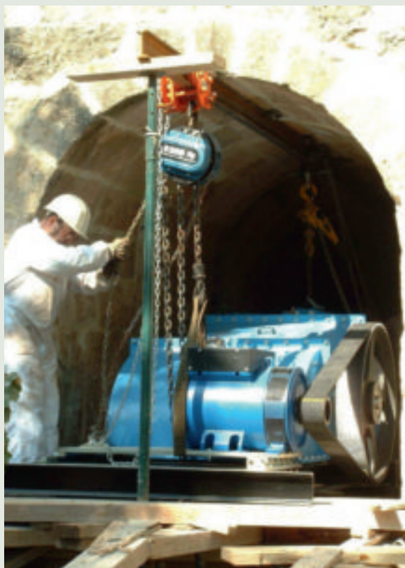
Figura 11. Trabajos manipulación turbina Banki 15kW
